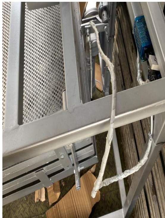
Imagen 8. Cableado forrado con cinta de papel
